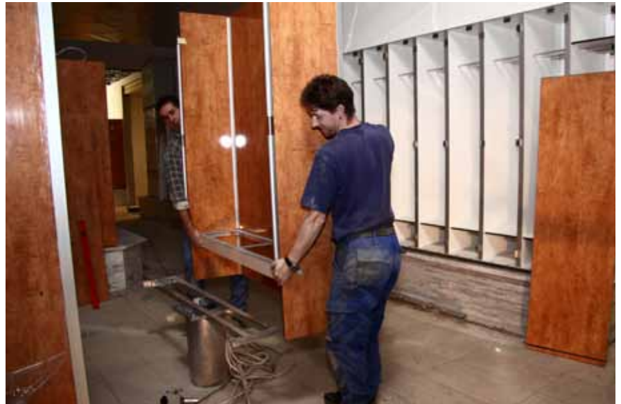
Montage der vormontierten Umkleiden auf der Grundkonstruktion
