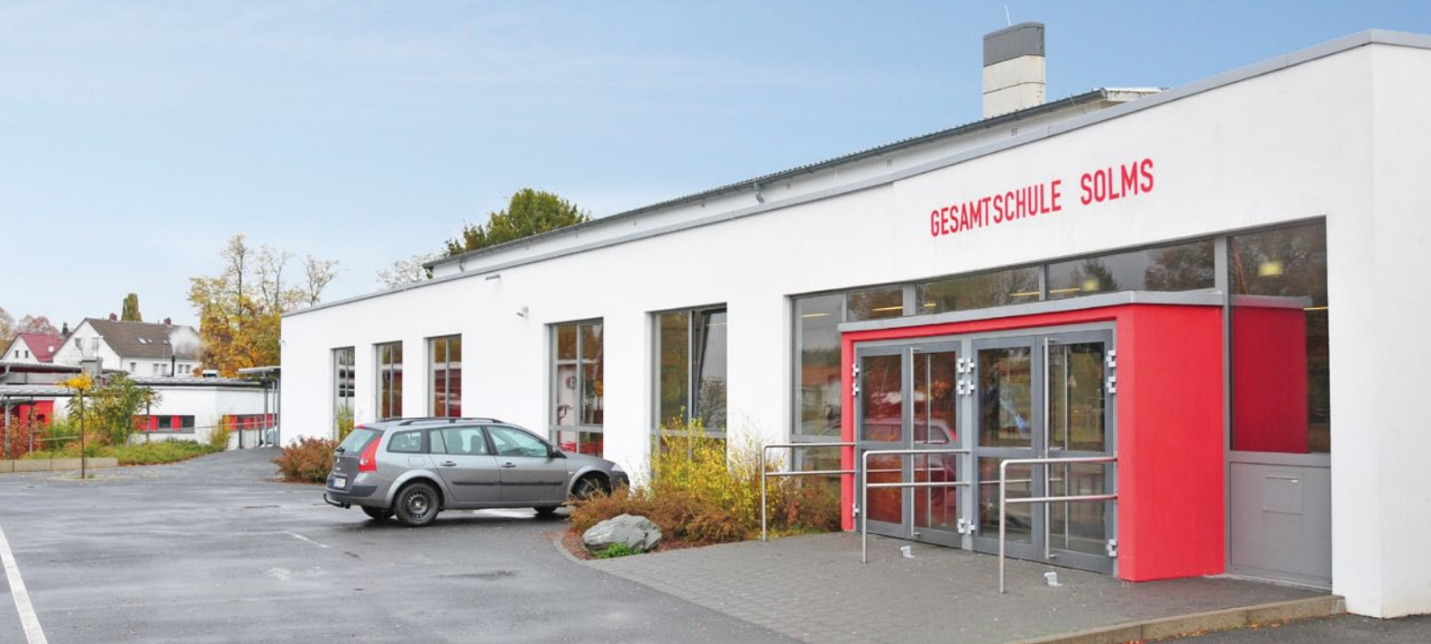
Sanierung der Gesamtschule in Solms
