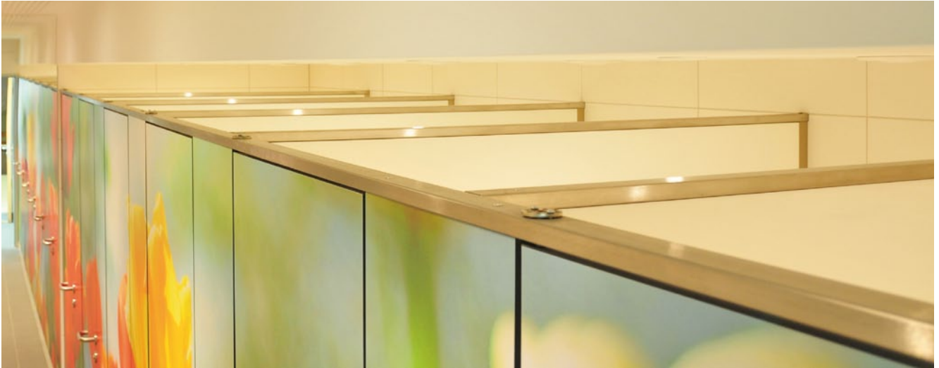
Detailansicht Kopfleiste Vorderwand und Mitteltrennwände
