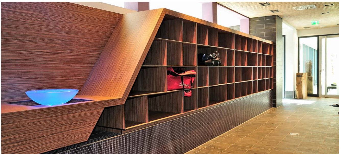
/// Oben: Individuell gefertigte Ablagefächer und Wandverkleidungen aus HPL, Dekor Zebrano, im Saunabereich. Unten links: Ablage mit Hakenleiste aus Aluminium im Duschbereich der Saunen. Unten rechts: Zwischen den Umkleideräumen und den Saunabereichen bieten großzügige Ablagefächer ausreichend Platz für Handtücher, Taschen etc.
