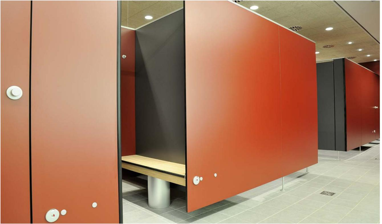
Die Umkleidekabinen wurden mit dem Trennwand-Typ S36 realisiert, der aus HPL-Verbundelementen mit B1-Hartschaumkern (Stärke 36mm) hergestellt wird. Die beidseitig mit 3 mm HPL-Schichtstoffplatten belegten Trennwände erhalten ihre hervorragende Stabilität und Formhaltigkeit durch eine
