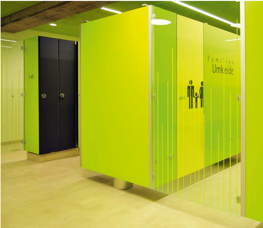
/// Links: Deutlich erkennbar: Die Grundkonstruktion ruht auf einem zentralen Mittelfuß, der es ermöglicht, die Umkleiden ohne herkömmliche Trennwandfüße zu gestalten. Rechts: Die Glaselemente zwischen Stiefelgang und Umkleidebereich dienen auch als Fluchttüren.
