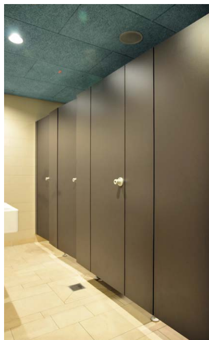
/// Links: Neben Einzel- und Sammelumkleidekabinen stehen Familien auch separate Umkleidekabinen zur Verfügung. Rechts: Statisch notwendige Füße der Trennwandanlage S36 FLY sind zurückversetzt und lassen die Wände „schweben“.
