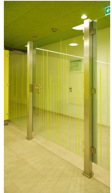
/// Links: Deutlich erkennbar: Die Grundkonstruktion ruht auf einem zentralen Mittelfuß, der es ermöglicht, die Umkleiden ohne herkömmliche Trennwandfüße zu gestalten. Rechts: Die Glaselemente zwischen Stiefelgang und Umkleidebereich dienen auch als Fluchttüren.
